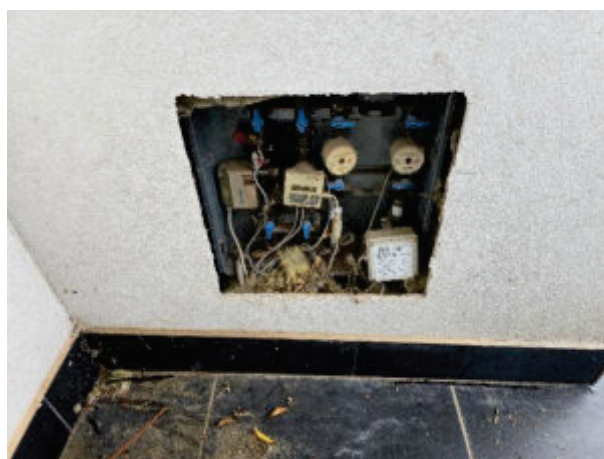
Contabilizzatore di calore non funzionante e ormai datato
