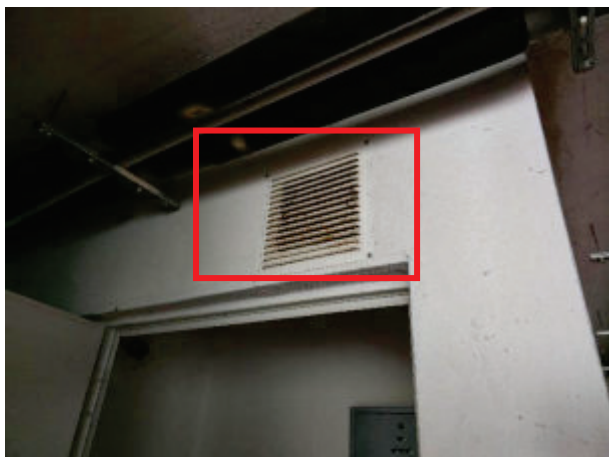
Assenza di una griglia antifuoco per ventilazione naturale
