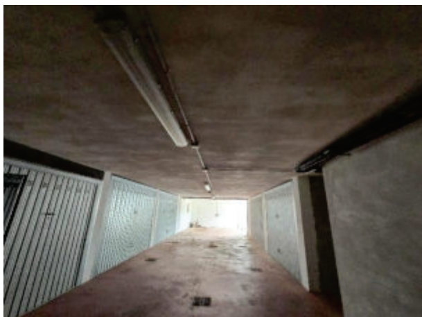
Corsia di manovra autorimessa condominiale con soffitto in laterocemento con intonaco semplice, assenza di estintori
